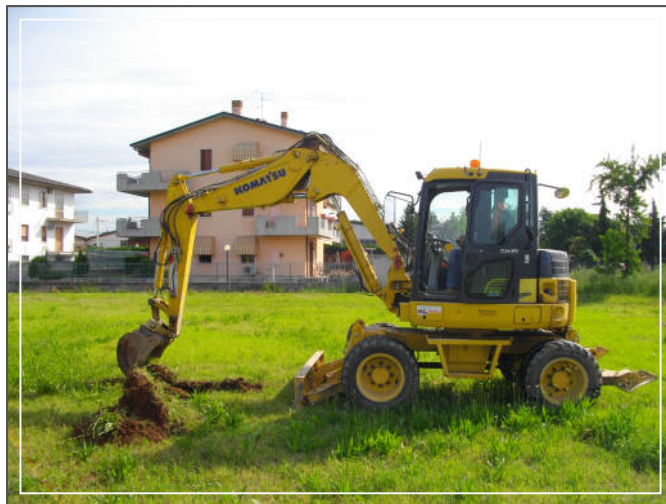
POSTAZIONE DELLA PROVA PP1
