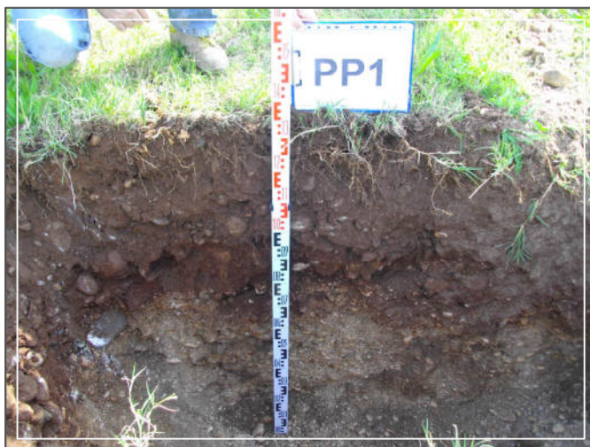
PARETE DI SCAVO DELLA PROVA PP1
